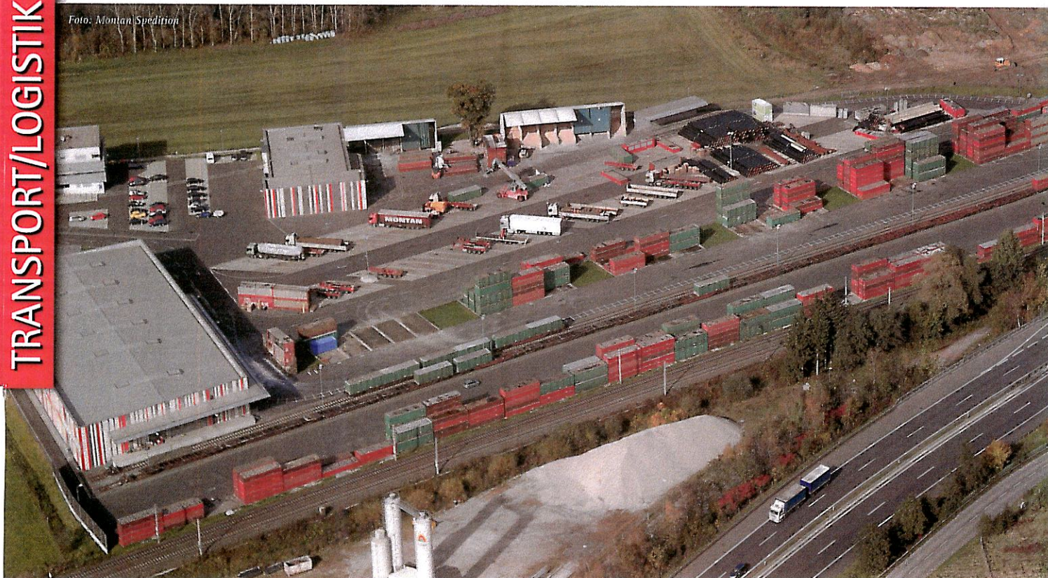
Obersteirische Bahnlogistik aus der Vogelperspektive: Blick auf den Montan Terminal in Kapfenberg.
